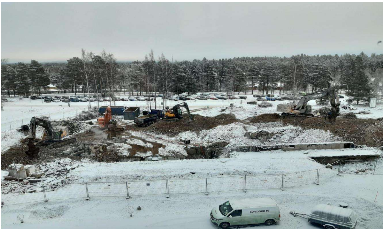
Aika aikaansa kutakin. Kainuun keskussairaalan purkutyömaa 9.11.2022.
